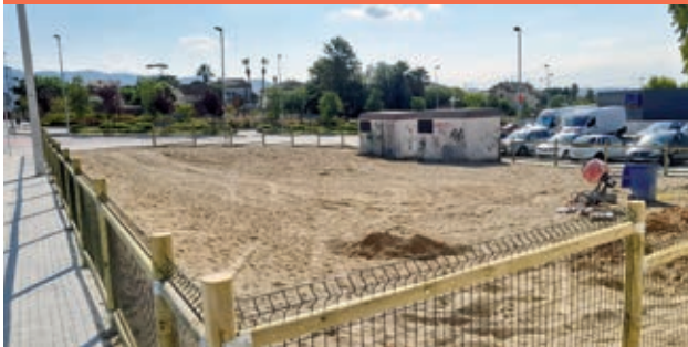
● Construcción del correcán de la calle Claverol con Sant Vicenç
